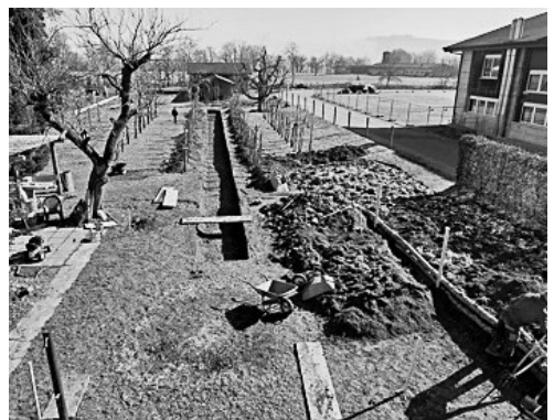
Bau der Hochsprunganlage
